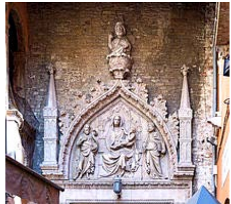
Particolare del portale al lato della chiesa, oggi ancora visibile andando da Campo San Provolo verso la Chiesa di San Zaccaria.
